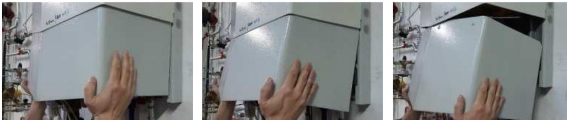
Klinger-FWF50HV – den unteren Teil der Abdeckung nach vorne ziehen, bis sich diese aus den seitlichen Führungsschienen aushängt und somit zu entfernen ist.
