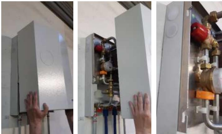
Klinger-FWF40, FWF50N – den unteren Teil der Abdeckung etwa 1-2cm anheben, unten nach vorne ziehen. Wenn die Abdeckung nun unten schräg nach vorne steht, diese nach unten wegziehen und entfernen.
