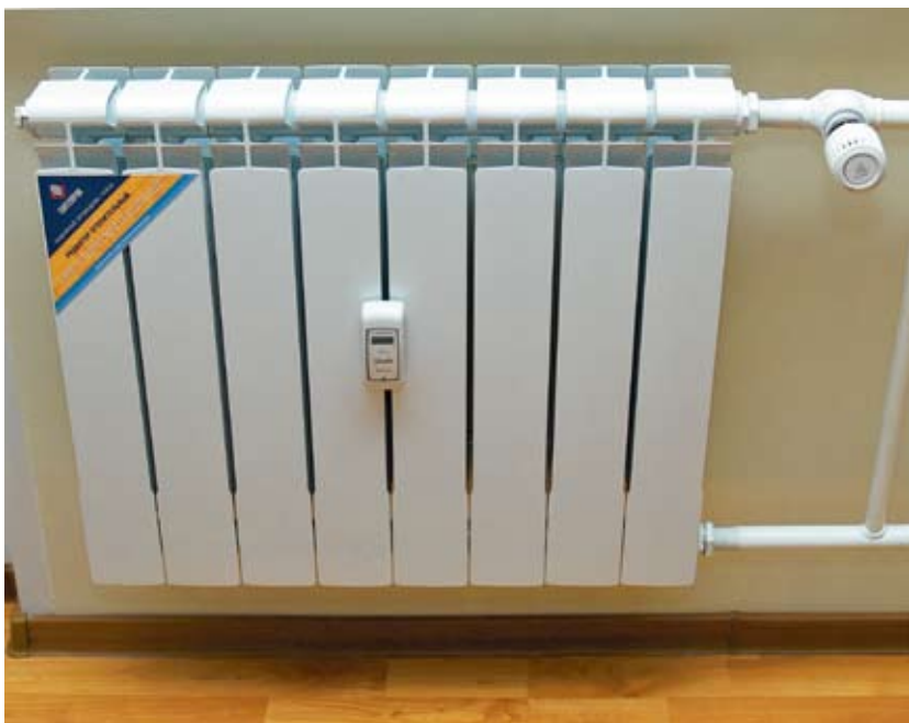
Однотрубная система отопления, оснащенная автоматическими балансировочными клапанами АВ-QM с термостатическими элементами QT
