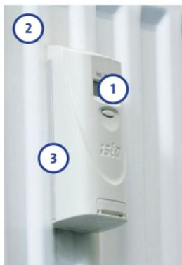
Le coefficient de couplage est différent en fonction du type de chaque radiateur.
