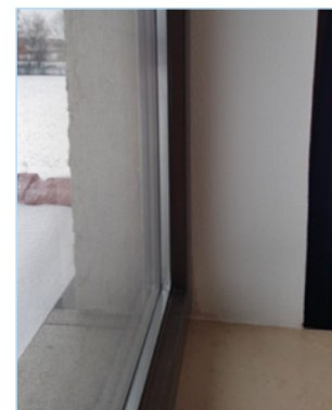
3.2 Fassade innen mit Fensterlaibung
