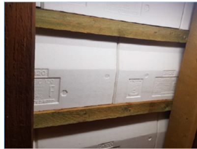
5.3 Dämmung bei Warmdächern
