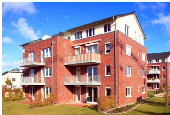
1.1 Gebäude außen, Front- oder Rückansicht
