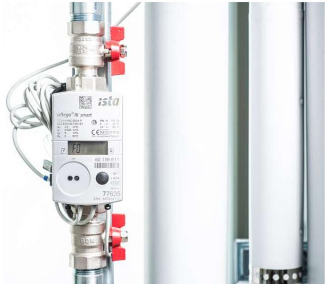
L'installazione di 4.000 contatori ultego III smart, collegati alle centraline prevalentemente tramite cablaggio M-bus, permette la lettura e la comunicazione dei dati al sistema automatico di gestione
