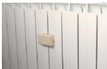
Ilustración 6. Evaporímetro.
