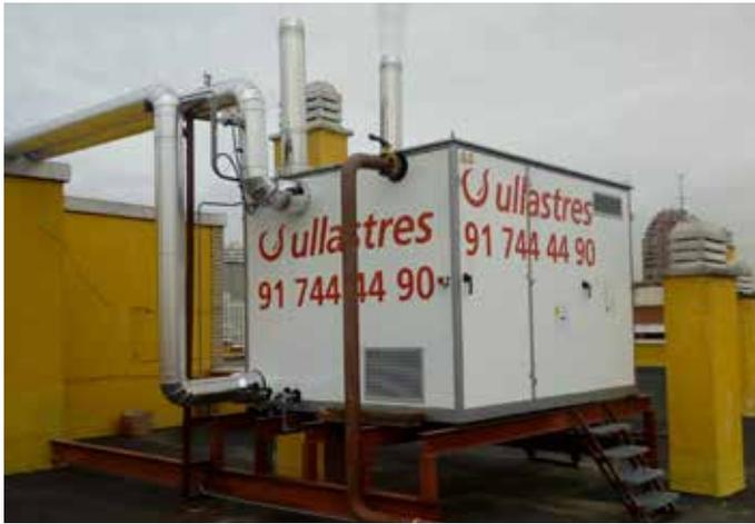
Figura 8.4 Equipo autónomo de gas ubicado en cubierta
