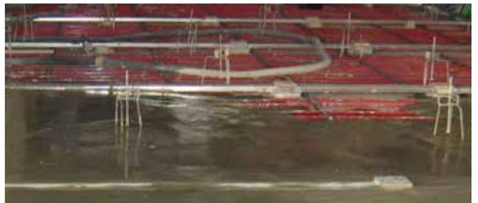
**Figura 3.47** Suelo radiante. Fuente: Eneres.
