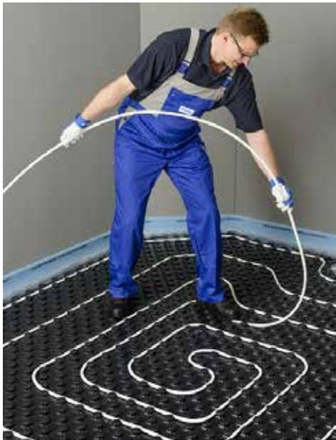
Figura 6.31. Instalación de tuberías plásticas de polietileno reticulado.
