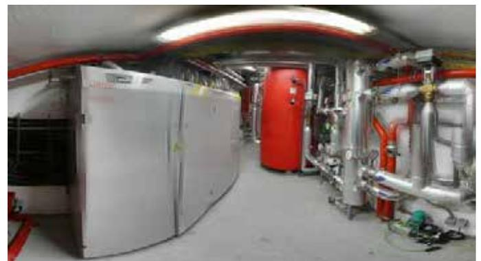
**Figura 3.49** Sala técnica de una instalación centralizada de calefacción mediante geotermia y elementos radiantes. Fuente: Eneres, 2019.
