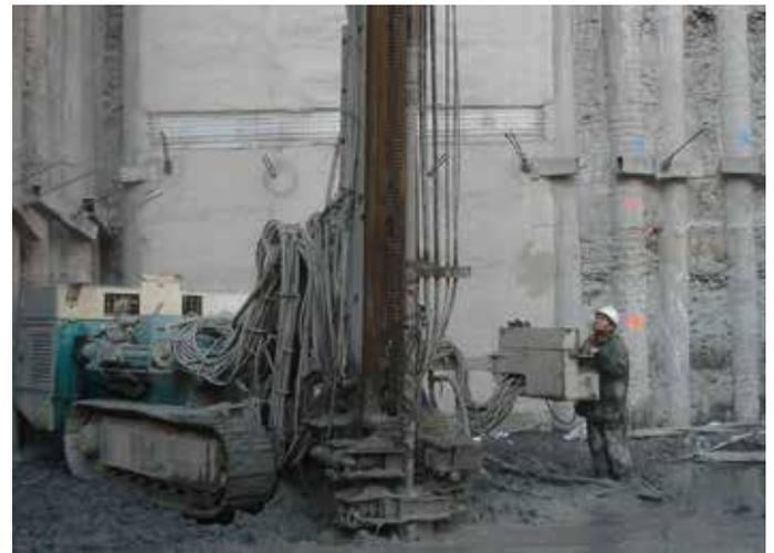
Figura 3.50 Perforación de pozos geotérmicos. Fuente: Eneres.
