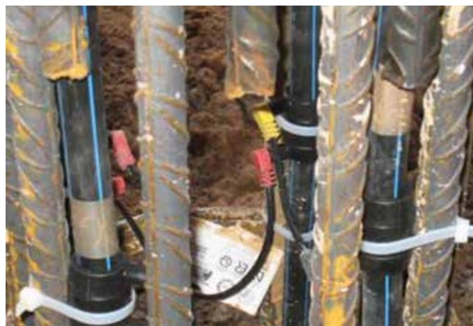
**Figura 3.53** Ejecución de pilotes geotérmicos. Fuente: Eneres.
