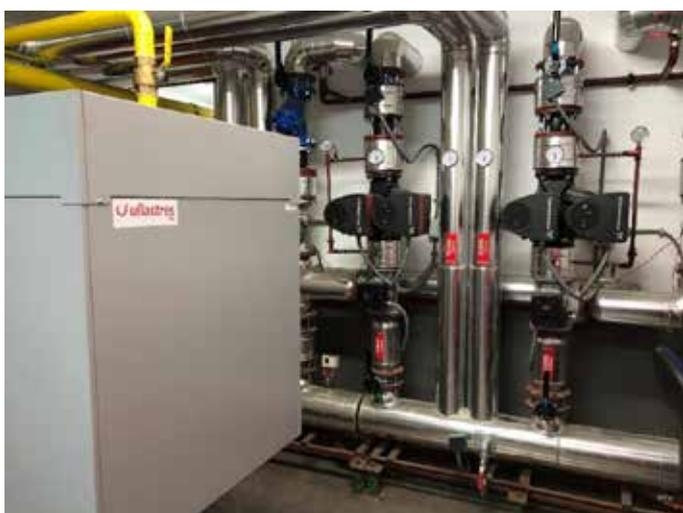
Figura 8.3 Colectores de distribución con bombas de caudal variable
