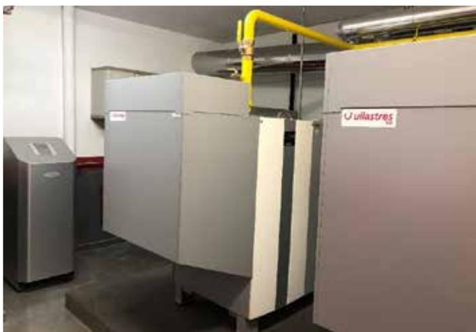
Figura 8.2 Central térmica con calderas de gas de condensación
