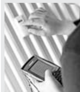
Instalación de un repartidor de costes en un radiador. | ISTA
