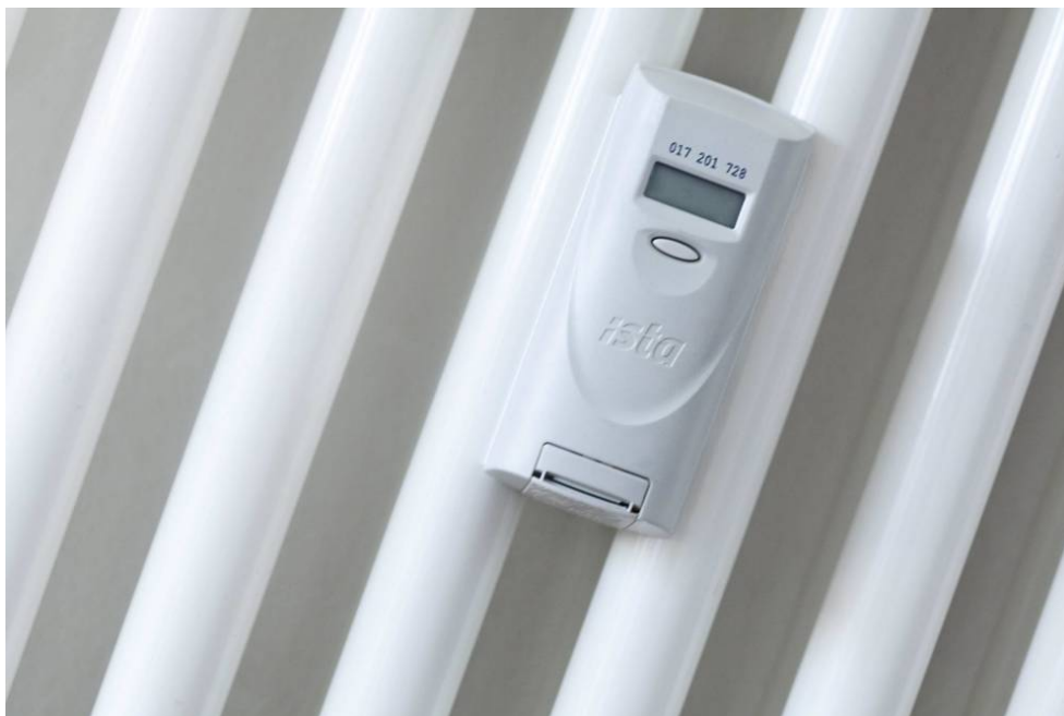
Así es un repartidor de costes de calefacción. (Foto: Ista)
