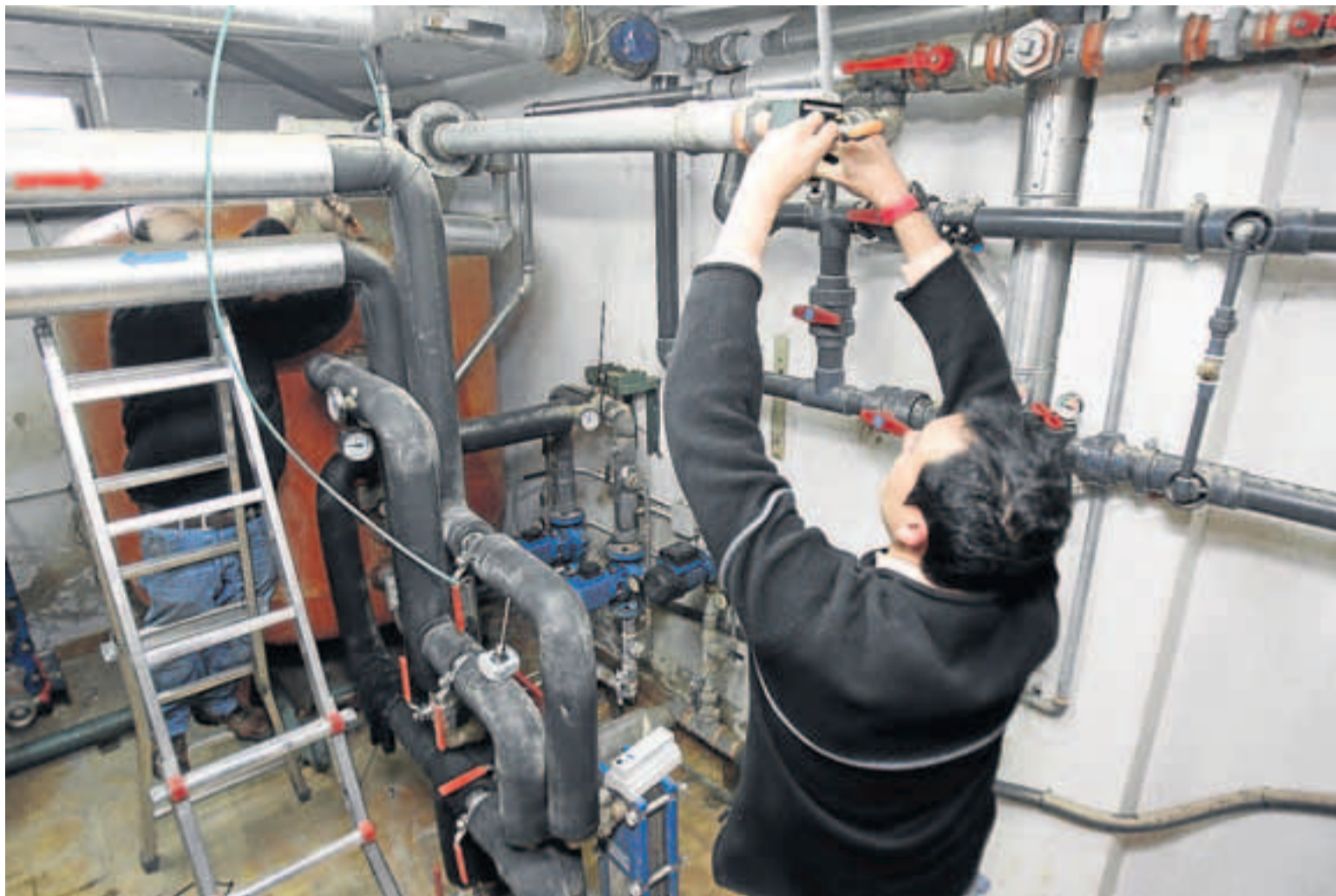
Un técnico realiza un ajuste en la sala de calderas de un inmueble de Miranda de Ebro. :: AVELINO GÓMEZ
