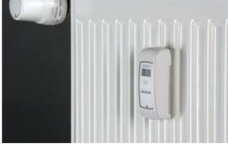
Şekil 6. Isı Pay Ölçer Montajı
